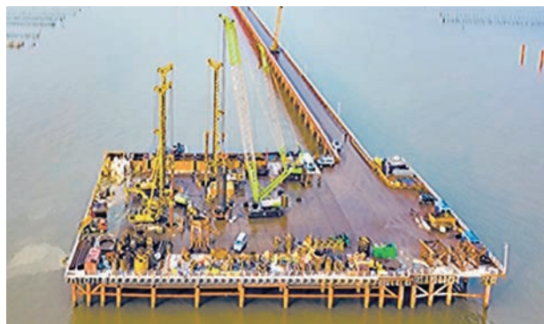
建設中の黄茅海大橋
