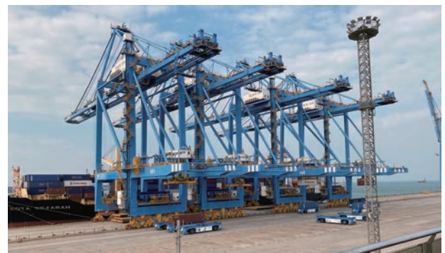
無人運転のガントリークレーンとAGV
