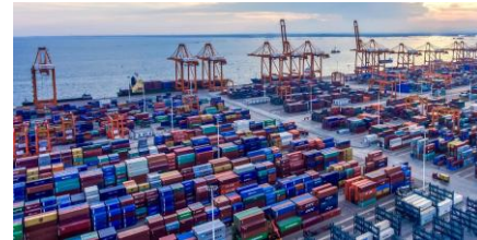
欽州港コンテナターミナル
